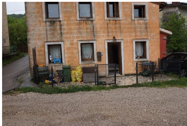
Vista Particolare ingresso su fronte nord fabbricato
