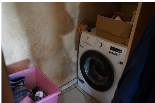
Piano Terra – Sottoscala
