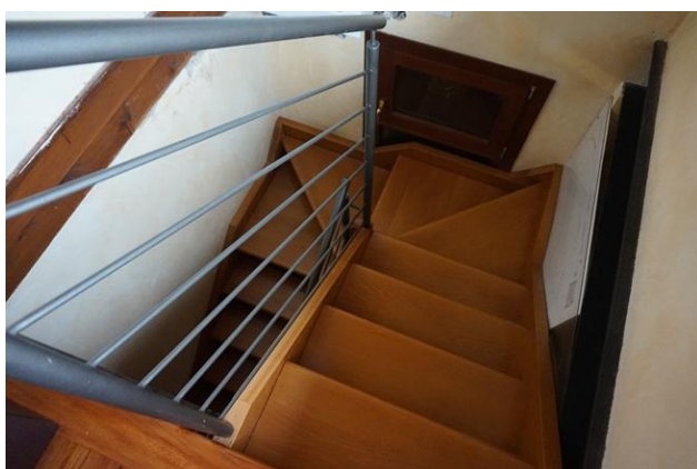
Piano Secondo – Scala da piano primo
