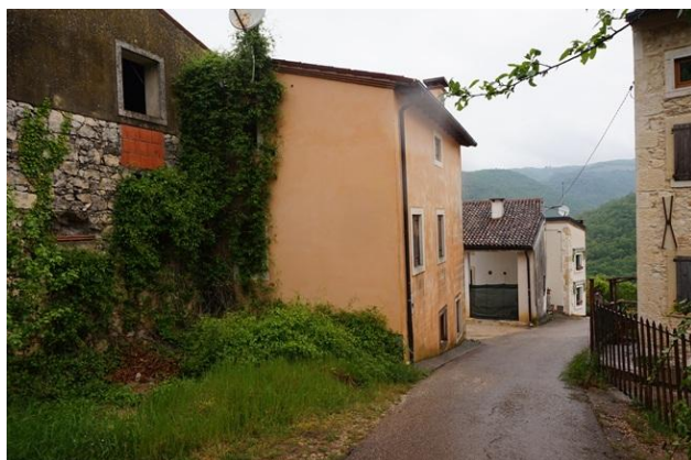
Fronte sud fabbricato da via Casalin
