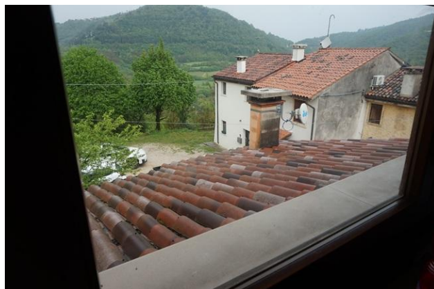
Corte comune vista da sottotetto piano secondo
