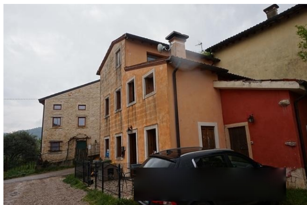
Fronte nord e ovest fabbricato da corte comune
