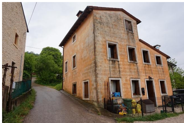
Fronte nord e est fabbricato da via Casalin
