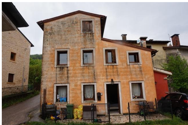
Fronte nord fabbricato da corte comune
